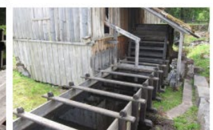
Intagsrännan i trä som leder fram till vattenhjulet i sågen (2).
