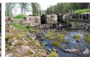
Dambyggnaden från söder med utskav, överfall och intag.
