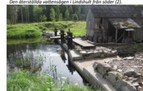
Dammen vid vattensågen (1) från västra sidan.
