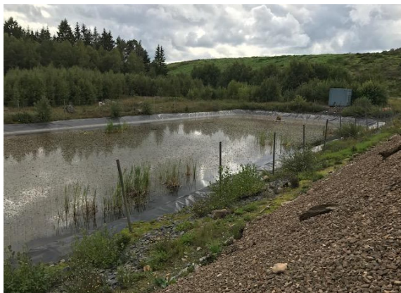
Figur 32. Uppsamlingsdamm där dagvattnet från diket hamnar. I bakgrunden syns det lilla reningsverket och kullen i bakgrunden är den nedlagda deponin.
