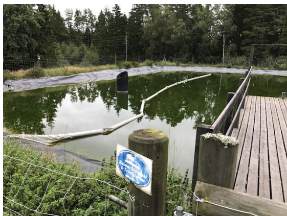
Figur 26. Luftningsdamm för lakvatten från Linneberga deponi.
