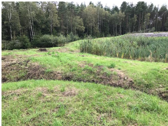
Figur 29. Sandfilter i bakgrunden, poleringsdamm med kaveldun och slingrande svackdike i förgrunden på bilden.
