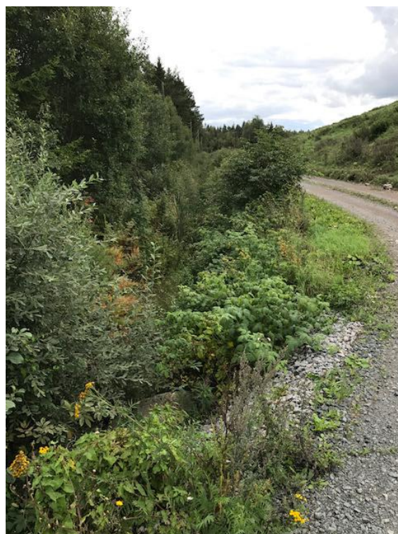
Figur 37. Diket som tar emot det renade utsläppsvattnet på vänster sida om vägen. Lakvatten från deponin går i täckdike på höger sida om vägen.
