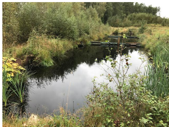
Figur 25. Sedimentationsdamm med skärmar för att fånga flytande material. Detta är en av de sista dammarna på Econovas område.
