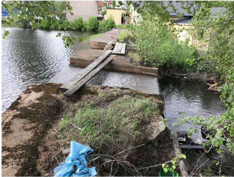
Figur 15. Dammen har ett överfall i form av ett skibord och stängda luckor. Drygt 2 m fallhöjd och definitivt vandringshinder för all fisk.
