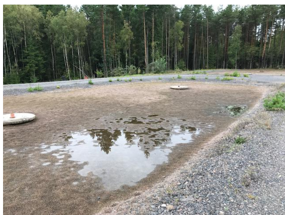
Figur 27. Sandfilter efter sedimentationstrumma.
