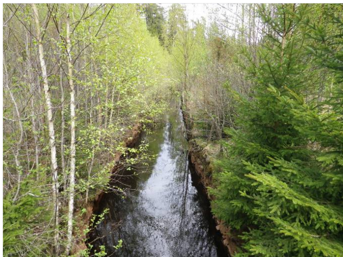
Figur 31. De närmsta ca 500 metrarna innan Sandsjön är kraftigt sänkta pga Sandsjöns sänkning. Kanterna är bitvis kallmurade. Foto: T. Nydén.
